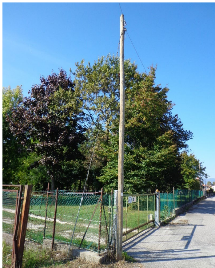
Foto dello stato di fatto, Via Egidio Sartor
