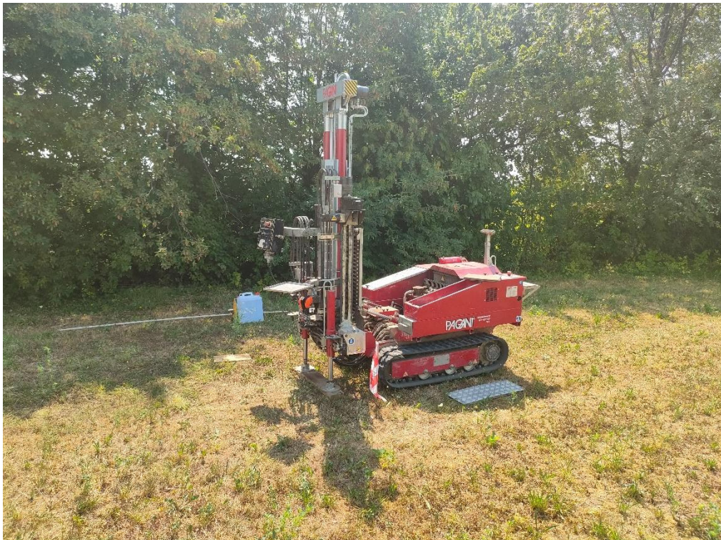
Foto n.4 – Esecuzione prova penetrometrica dinamica superpesante (DPSH4)
