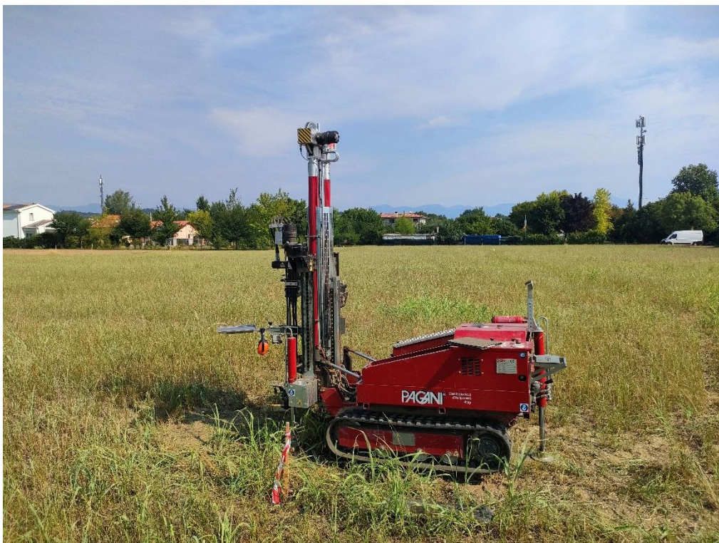
Foto n.2 – Esecuzione prova penetrometrica dinamica superpesante (DPSH2)
