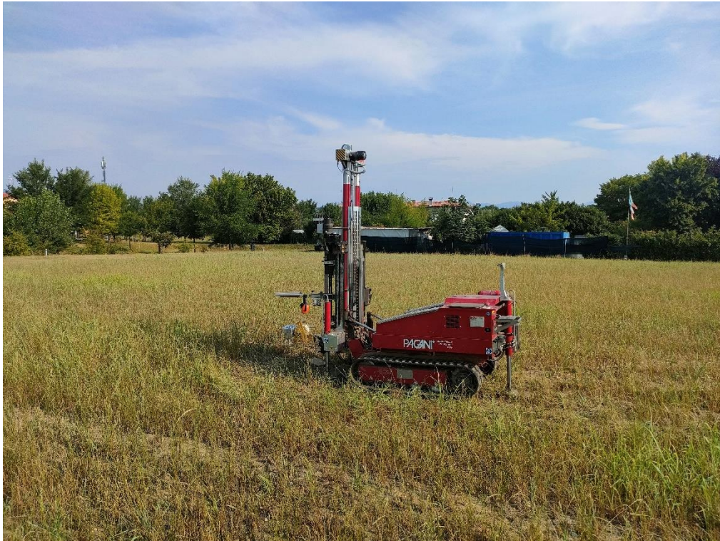
Foto n.1 – Esecuzione prova penetrometrica dinamica superpesante (DPSH1)
