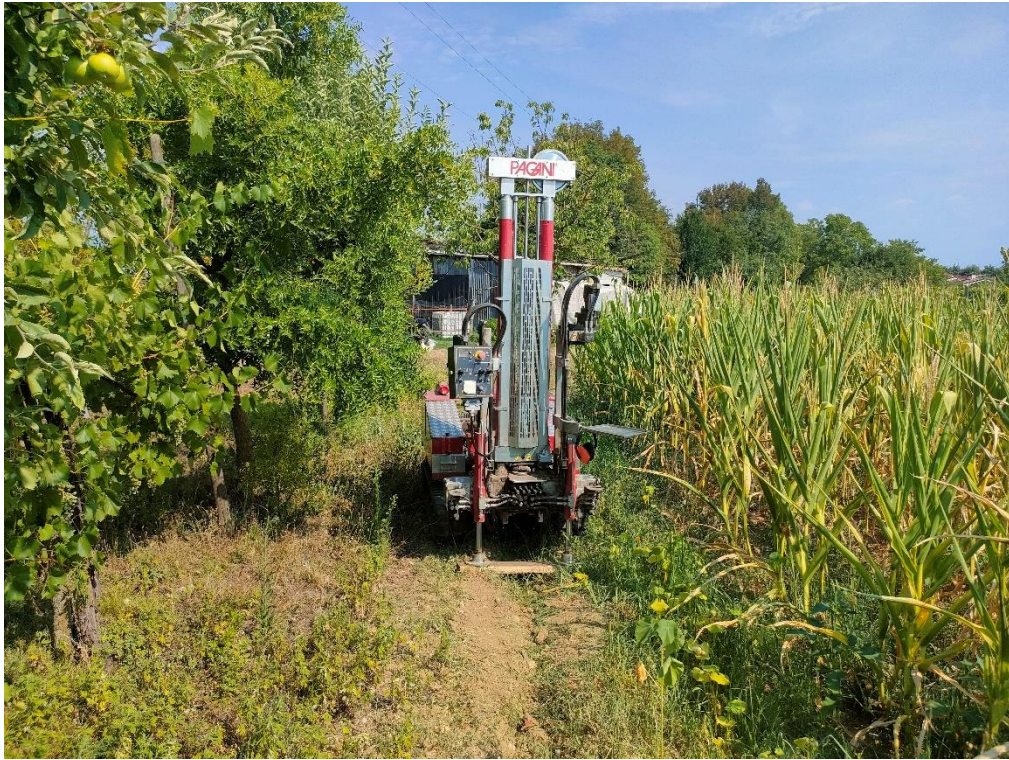
Foto n.3 – Esecuzione prova penetrometrica dinamica superpesante (DPSH3)
